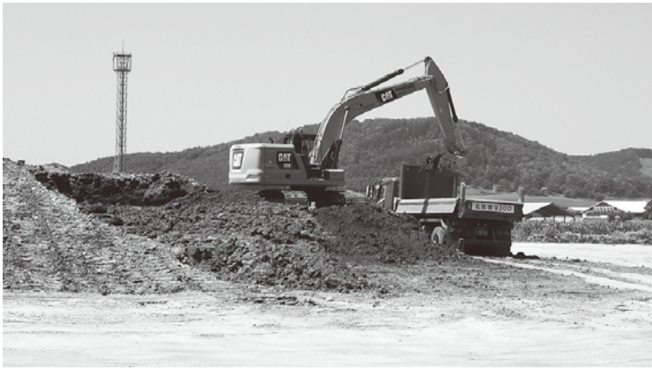
▲造成工事の様子
